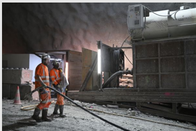
© G.J. Plisson / INRS / 2022 Éclairage à LED sur un chantier de BTP
