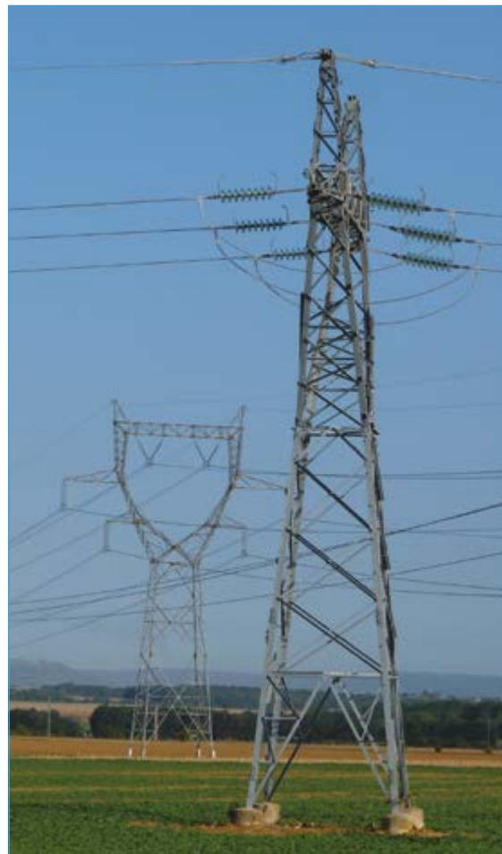
Figure 2. Deux lignes HTB : une ligne de 63 kV à proximité d'une ligne de 400 kV
