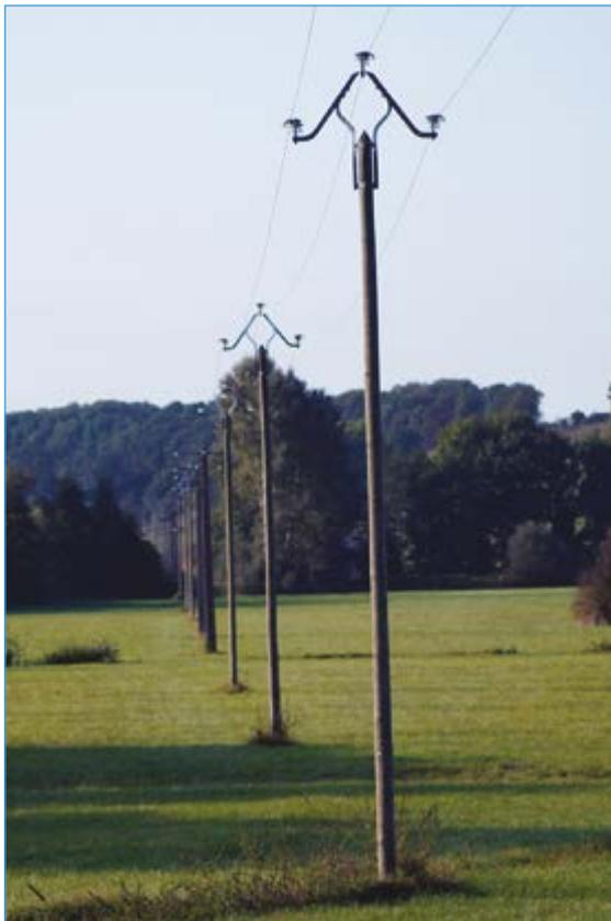
Figure 1. Ligne HTA de 20 kV
