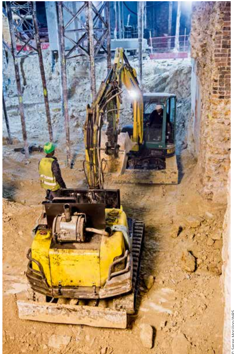
↑ FIGURE 3 Engins équipés de FAP dans un chantier souterrain.
