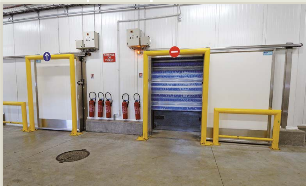
Figure 8. Dispositif de protection de porte
