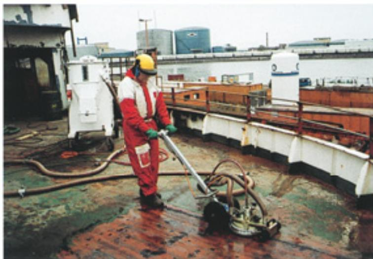
*Choix du procédé de travail : pour le décapage des sols, le chariot est préférable au pistolet (réduction du risque d'accident aux jambes, possibilité de récupération des boues à la source...).*
