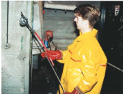
*Pour signaler l'imminence de la sortie de la tête de curage, on peut fixer des bagues ou anneaux de couleur sur le flexible...*
