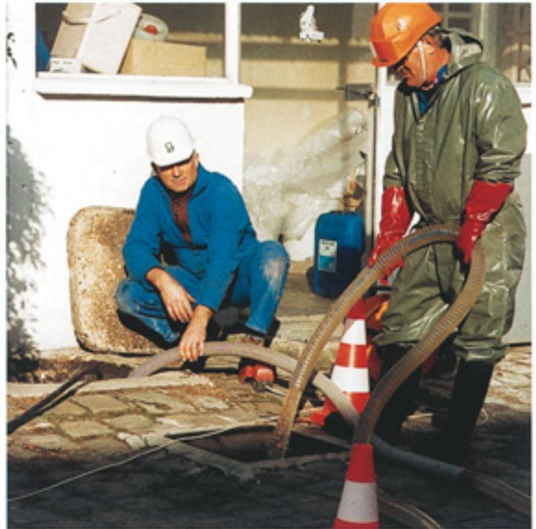
*Travail avec un hydroéjecteur. L'opérateur doit disposer d'une commande à action maintenue et l'extrémité de la gaine doit être maintenue fermement.*
