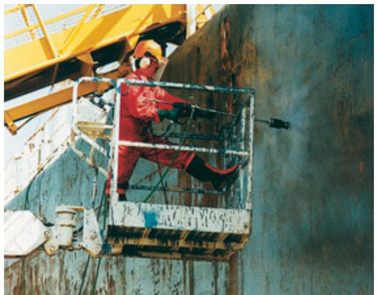
*Sauf impossibilité dûment justifiée, le canon doit être d'une longueur telle que l'opérateur ne puisse pas passer sa main devant la buse ou faire passer la buse au-dessus de ses pieds.*
