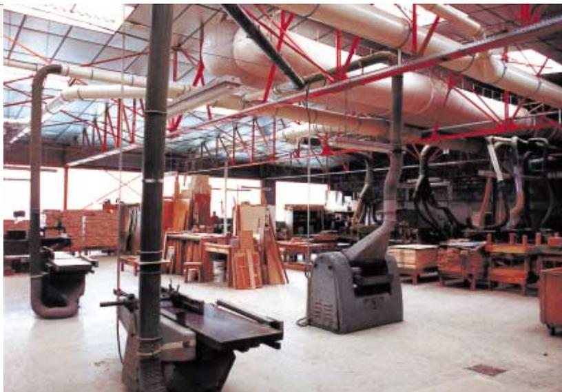
Une gaine diffusante, placée au plafond, assure la compensation d'air
