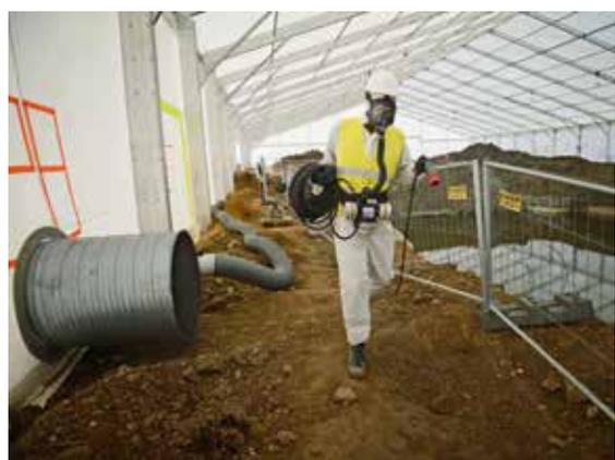
Lors d'une opération de dépollution et de réhabilitation d'un ancien site chimique, des opérateurs interviennent sous la tente pour réaliser des prélèvements de la nappe mise à jour.
