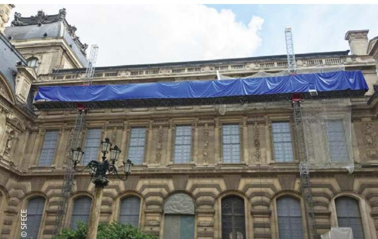
Fig. 39. PTDM avec dispositif antiprojection de matériaux
