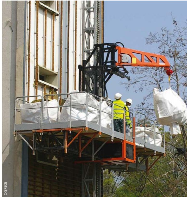
Fig. 6. PTDM mono-mât équipée d'une potence avec treuil d'approvisionnement
