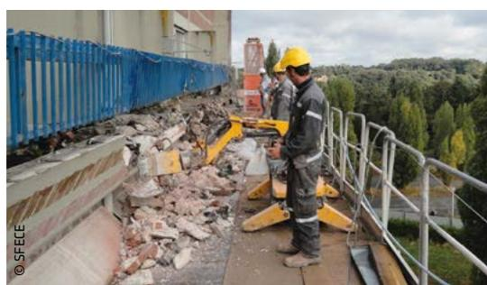
Fig. 40. Brise roche sur plate-forme de travail
