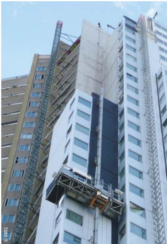
Fig. 7. PTDM mono-mât adapté à la forme du bâtiment
