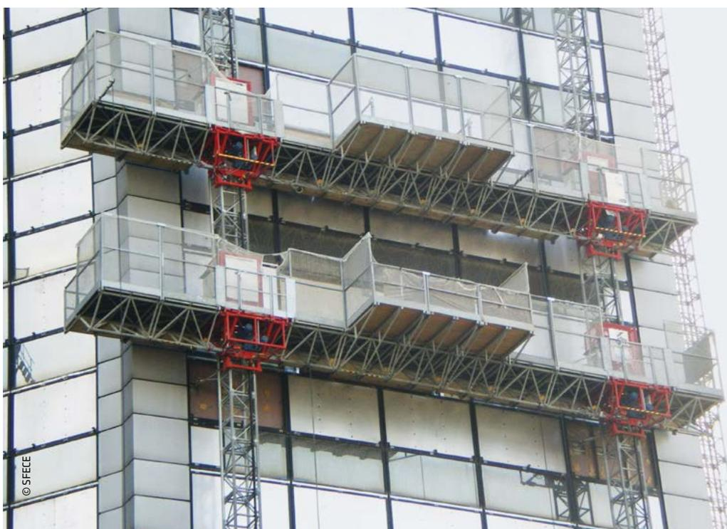
Fig. 13. PTDM bi-mât à double niveau (Chaque plate-forme fonctionne indépendamment.)
