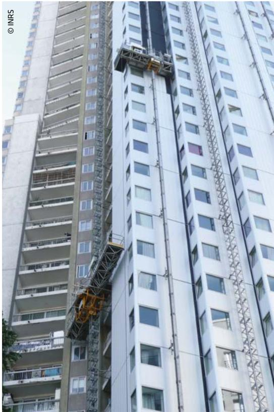
Fig. 5. Plusieurs PTDM mono-mâts en façade à fonctionnement indépendant
