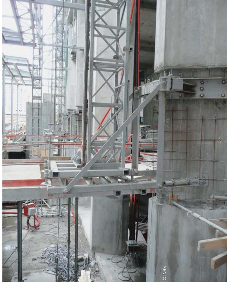
Fig. 27. Châssis sur console
