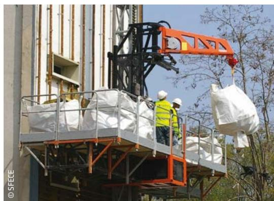
Fig. 41. Plate-forme de travail comportant un dispositif de levage d'approvisionnement
