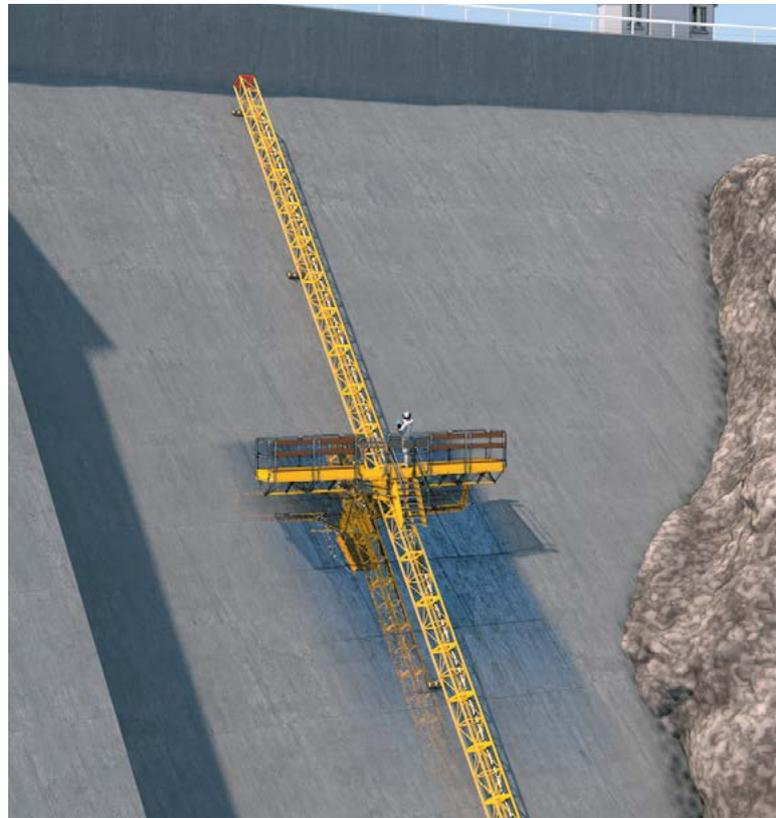
Fig. 8. PTDM mono-mât sur plan incliné
