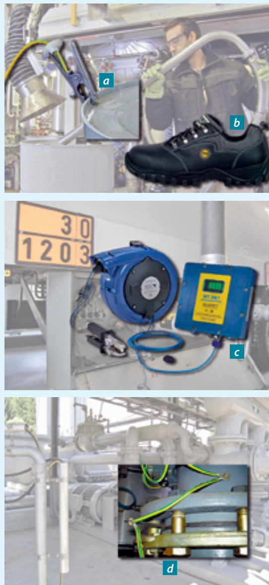
Figure 24. Exemples de mesures de prévention des décharges d'électricité statique : a) liaison à la terre de tous les éléments conducteurs (parties d'installations et produits) b) port de chaussures antistatiques c) contrôle de la liaison à la terre avec dispositif de verrouillage d) liaison équipotentielle des brides sur les conduites
