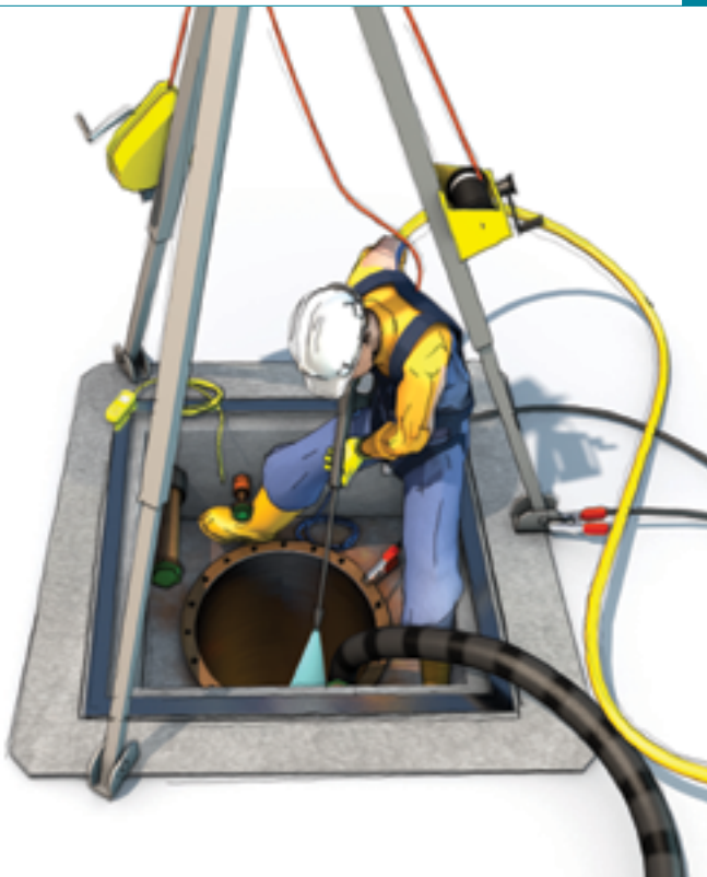
Figure 11. Phase de nettoyage sur cuve ouverte
