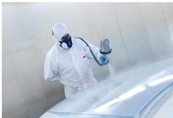
Quand les mesures de prévention collective ne peuvent être mises en œuvre, le recours aux EPI est indispensable. Ici port de protections adaptées en cabine de peinture automobile.
