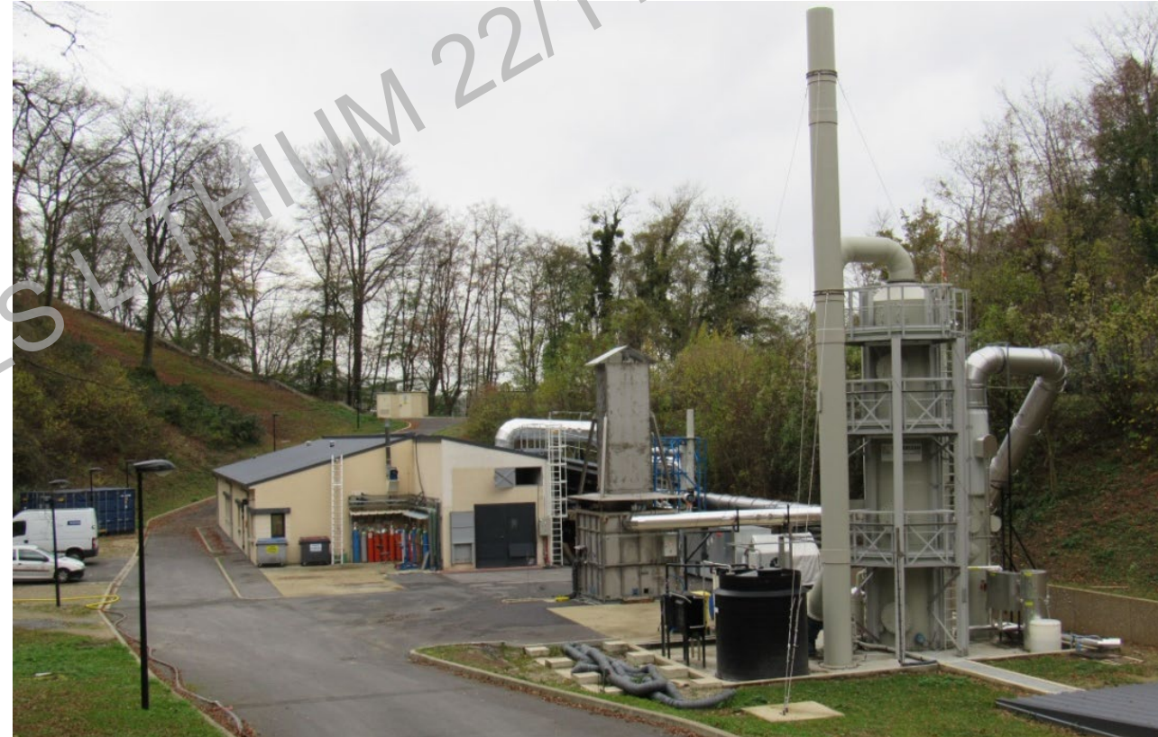
Plateforme d'essai Steeve: 240m 2 dédiée aux essais abusifs sur batterie, avec analyse de gaz et laveur
