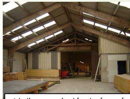
Atelier non isolé et séparé en deux par une cloison et deux locaux
