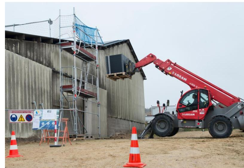
Solution conçue spécifiquement pour le levage de modules photovoltaïques et/ou adaptée en fonction du type de chantier, de son accessibilité et de sa taille
