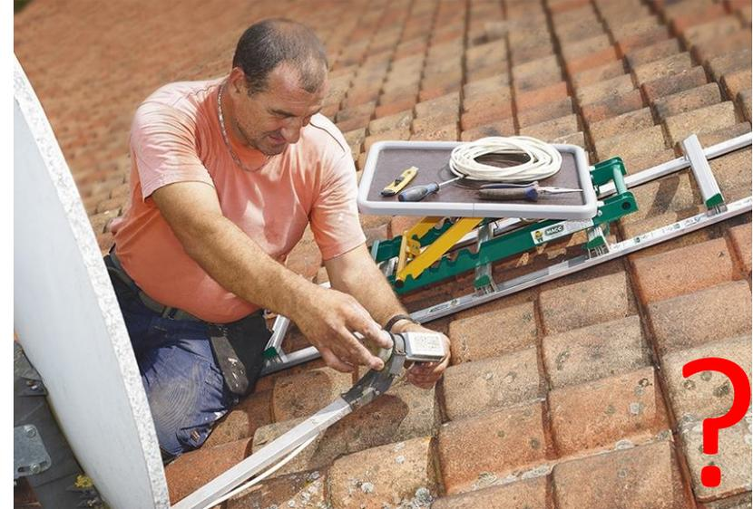
Les échelles de toit permettent de créer des chemins de circulation, faciliter l'accès notamment sur les toitures pentues et répartir le poids.
