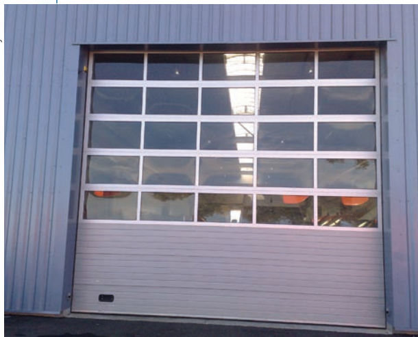
Porte sectionnelle ajourée pour augmenter la luminosité de l'atelier.
