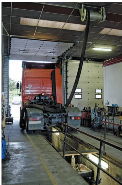
Dispositif de captage des gaz d'échappement branché sur un PL. Le flexible est installé sur un enrouleur en partie haute de l'atelier
