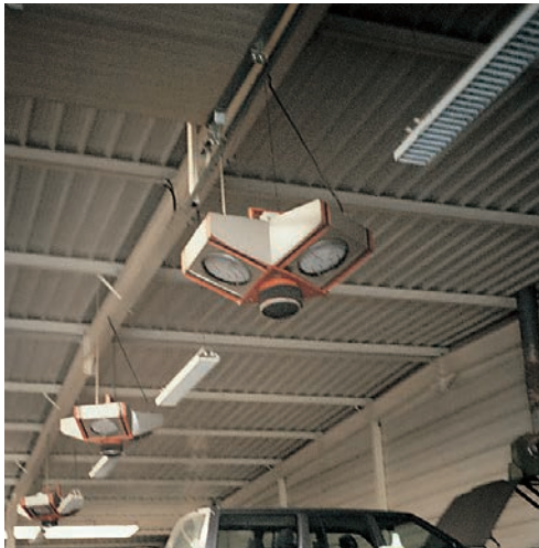
Réacteurs thermo-catalytiques étudiés pour le chauffage des locaux présentant un risque d'atmosphères inflammables ou explosives.
