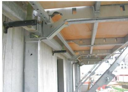
Boulons: en remplacement des écrous à ailettes
