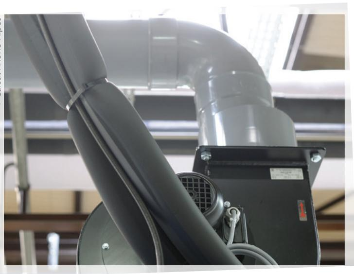
Photo 13 • Sortie d'air raccordée sur l'extérieur
