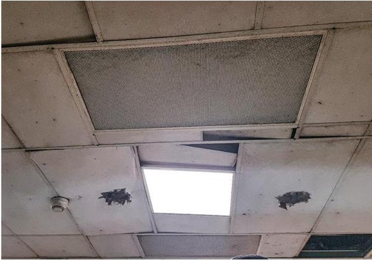
↑ PHOTO 1 Plafond de la cabine de tri : défaut d'ajustements et dégradations des plaques de faux-plafond.
