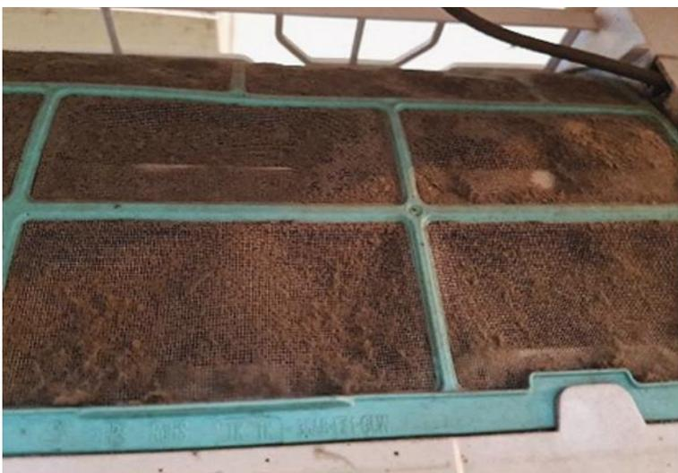
↑ PHOTO 3 Encrassement du filtre du système de traitement de l'air dans la cabine, lié à un défaut d'entretien.
