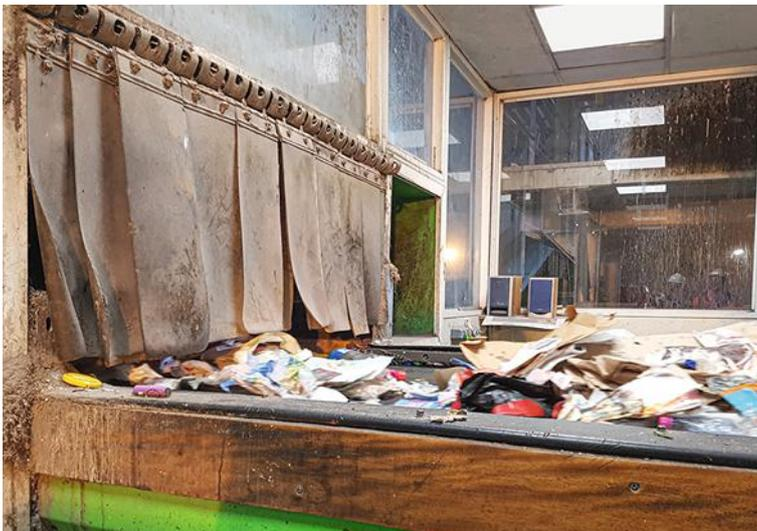
↑ PHOTO 2 Dépôts importants de poussières à l'intérieur de la cabine de tri. Lanières dégradées au niveau de l'entrée des déchets.
