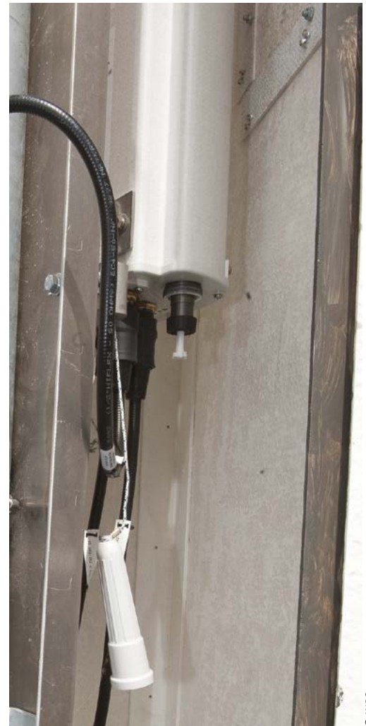
Photo 5. Dispositif de réglage de tilt
