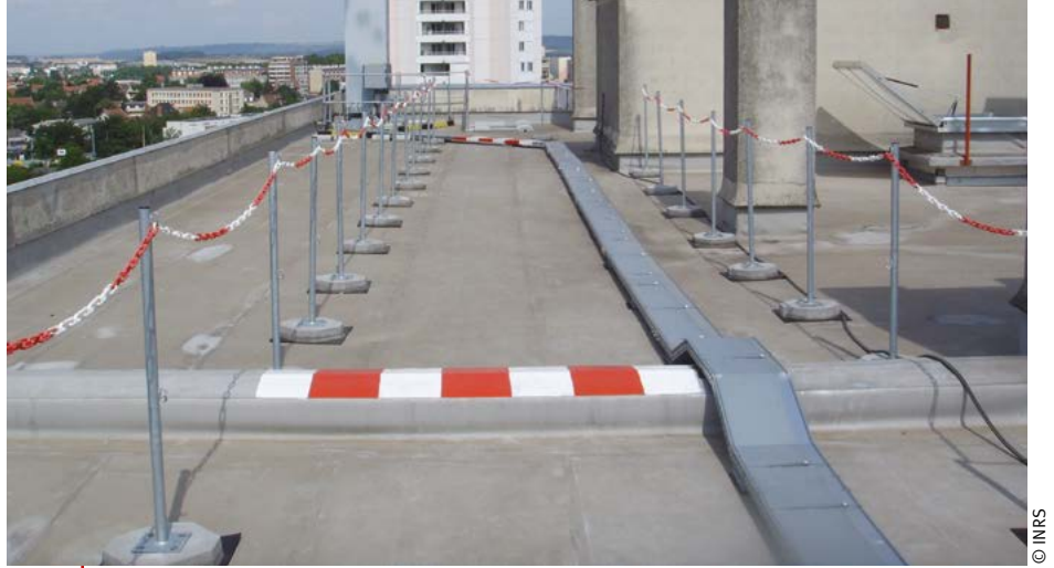
Photo 10. Cheminement en toiture avec balisage physique
