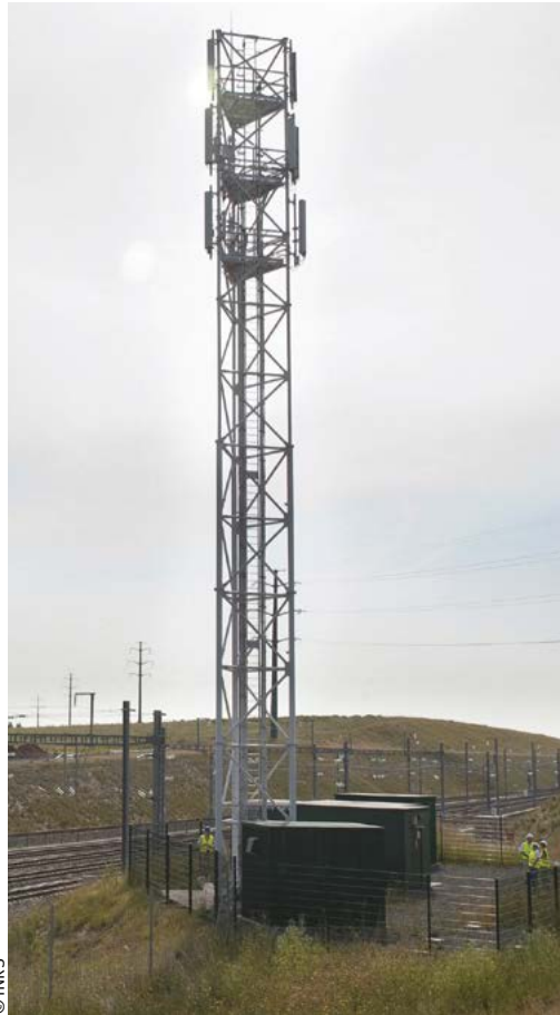
Photo 2. Antennes installées sur un pylône RFF
