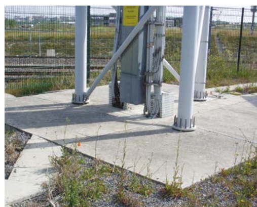
Photo 13. Chemin de câbles sous caniveau enterré
