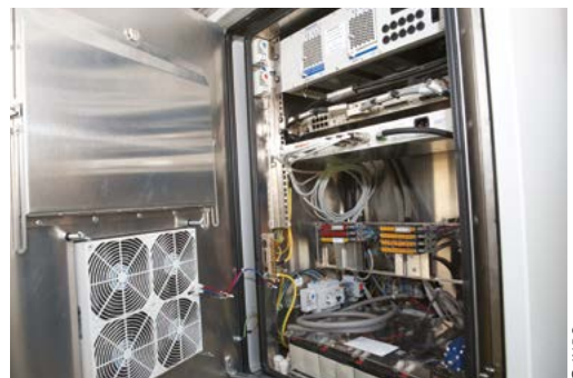
Photo 21. Exemple de baie
