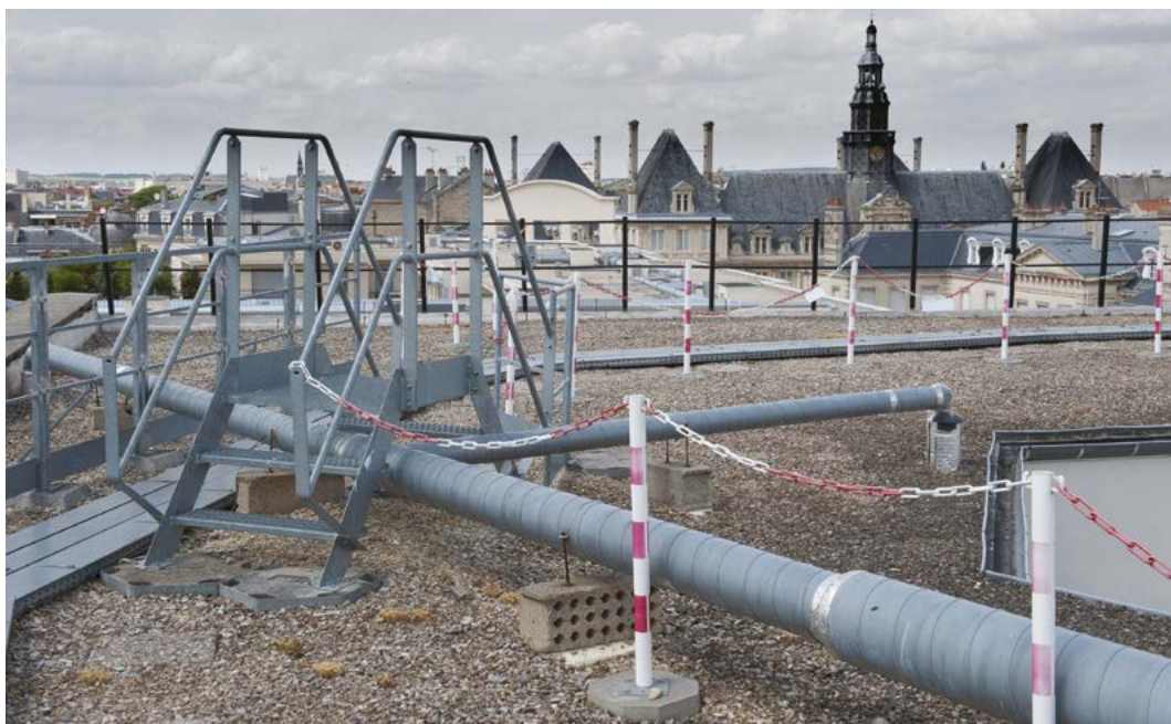
Photo 9. Passerelle munie d'un garde-corps dite « saut-de-loup »
