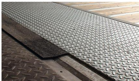
→ FIGURE 3 Traitement des irrégularités sur la zone des expéditions. À gauche : matériau amortissant de 6 mm d'épaisseur entre la fin de la lèvre et la plaque de renfort. À droite : bec métallique d'atténuation de l'effet marche (5 mm).
