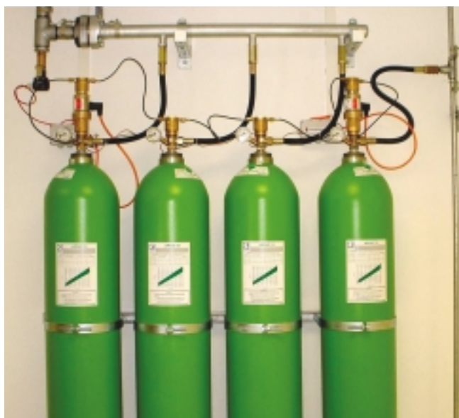
Fig. 3. Exemple de stockage d'IG 55 - Example of storage of IG 55
