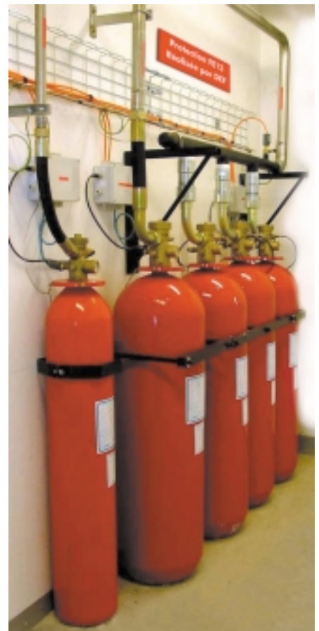
Fig. 5. Exemple de stockage d'HFC 23 - Example of storage of HFC-23
