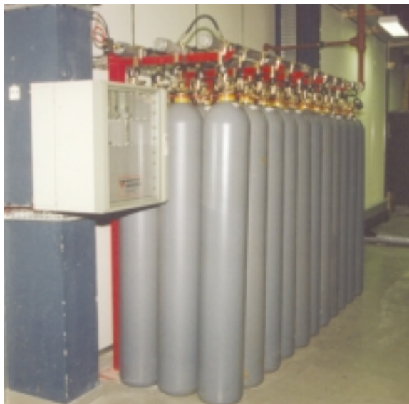
Fig. 2. Exemple de stockage d'IG 541 - Example of storage of IG 541
