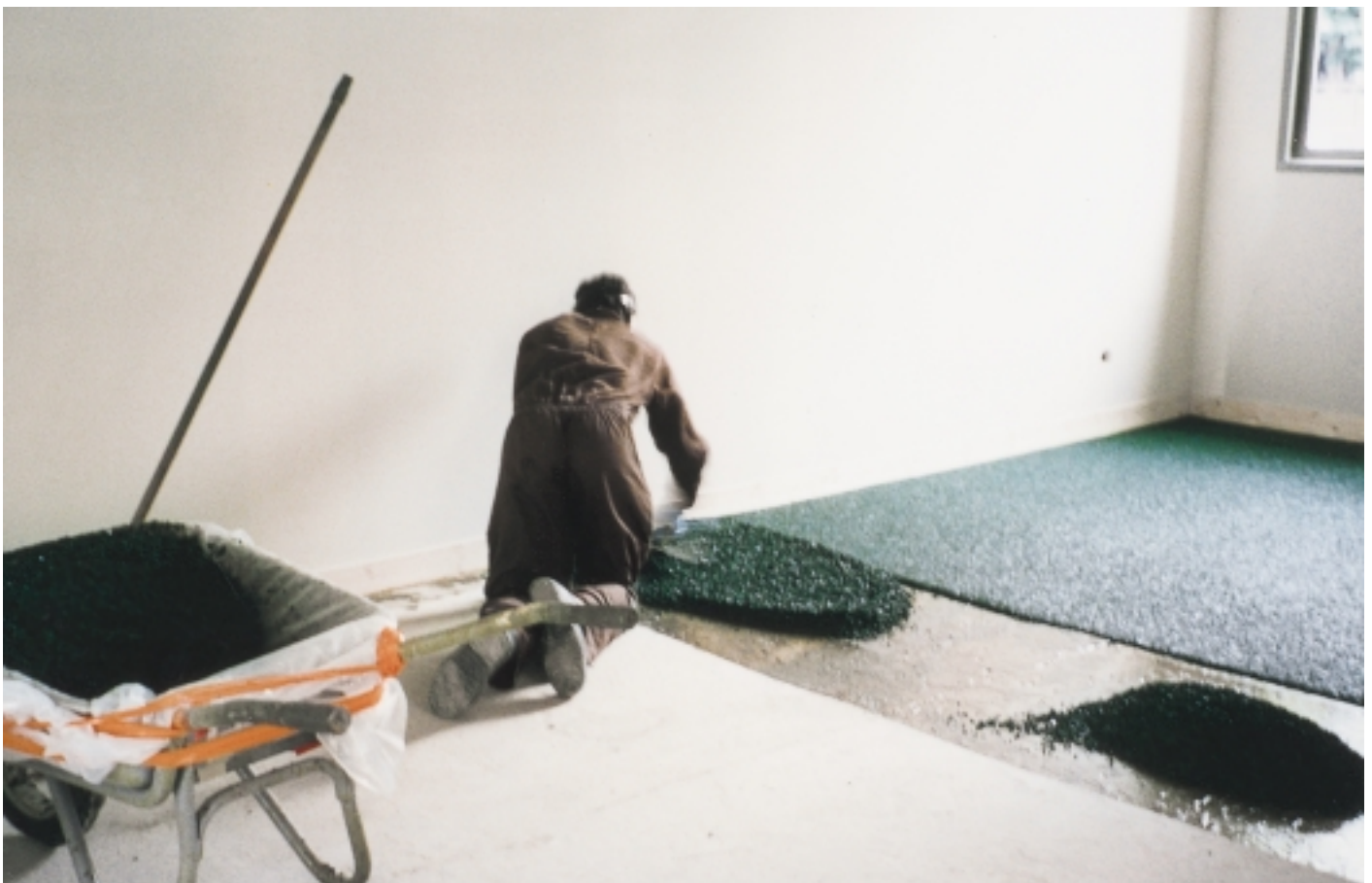
Fig. 2. Application du revêtement - Application of the coating
