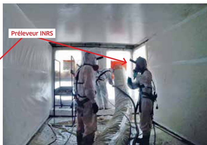
↑ FIGURE 6 Configuration de chantier n°3.
