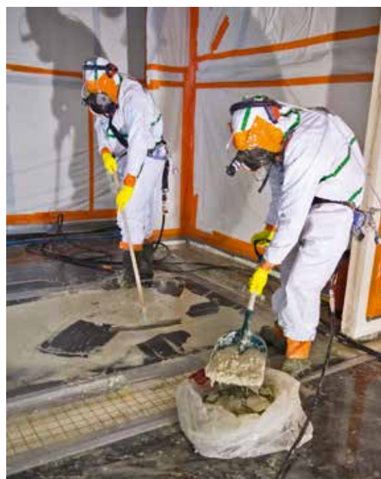
↑ FIGURE 3 Opération de ramassage de déchets de plâtres amiantés.
