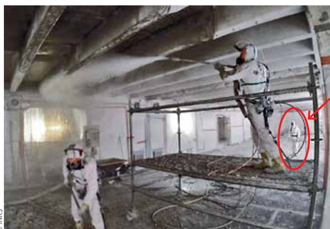
↑ FIGURE 5 Configuration de chantier n°2.
