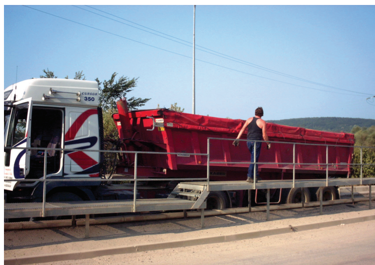
↑ FIGURE 3 Passerelle de bâchage/débâchage
