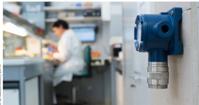
■ Photo 5 – Détecteur fixe de formaldéhyde dans un laboratoire d'anatomopathologie
