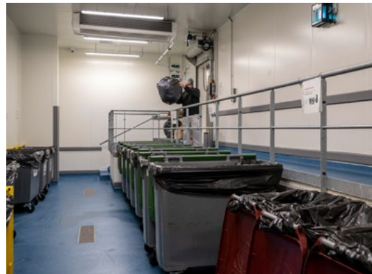
■ Sol du local à déchets d'une cuisine centrale
