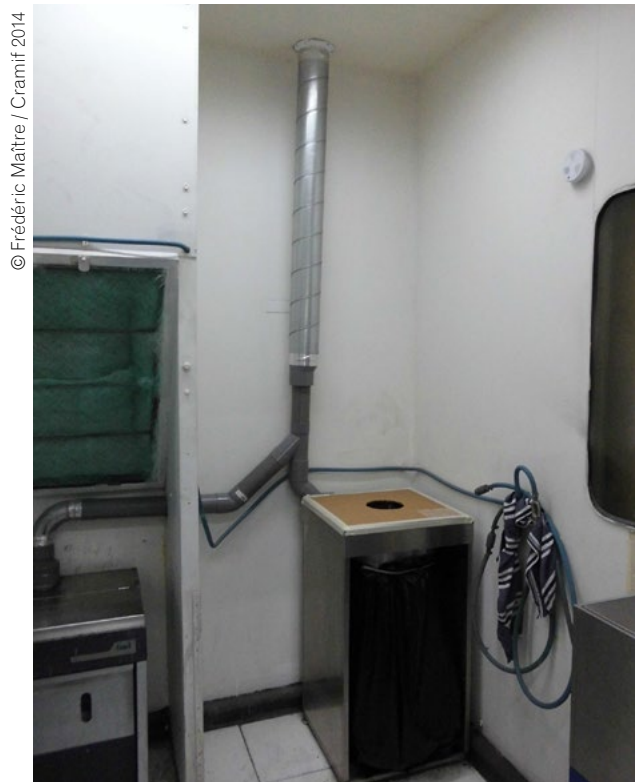
Photo 1. Poubelle ventilée après réduction de son diamètre d'ouverture.
