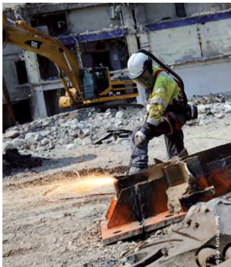
Chalumiste avec casque à ventilation assistée
