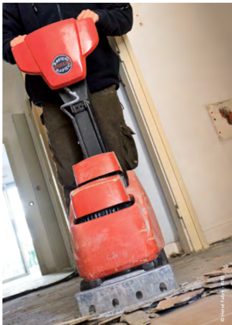
Retrait mécanisé de carrelage
