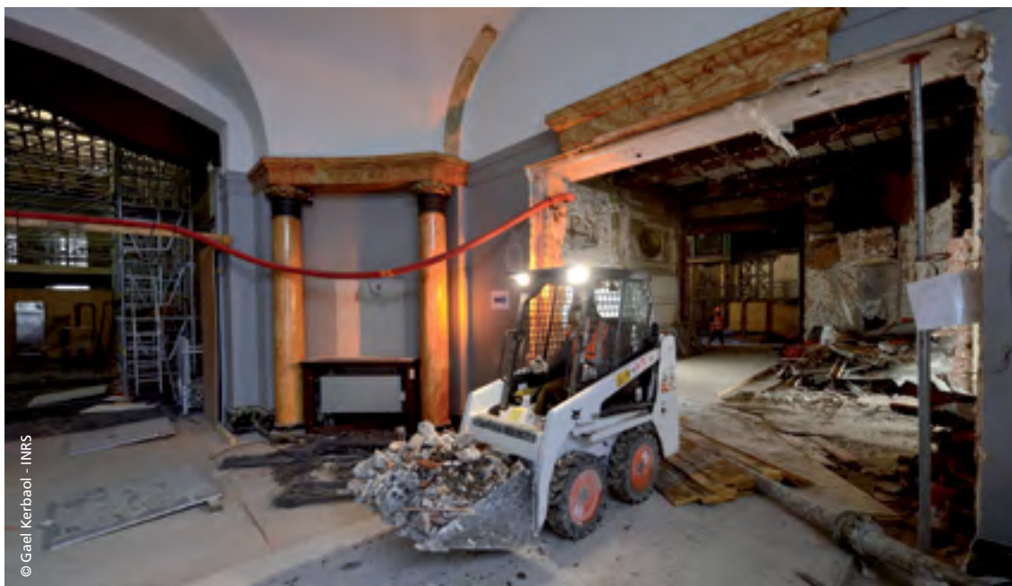
Manutention mécanisée de gravats
