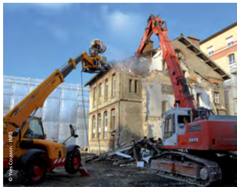
Abattage d'un bâtiment avec brumisation
