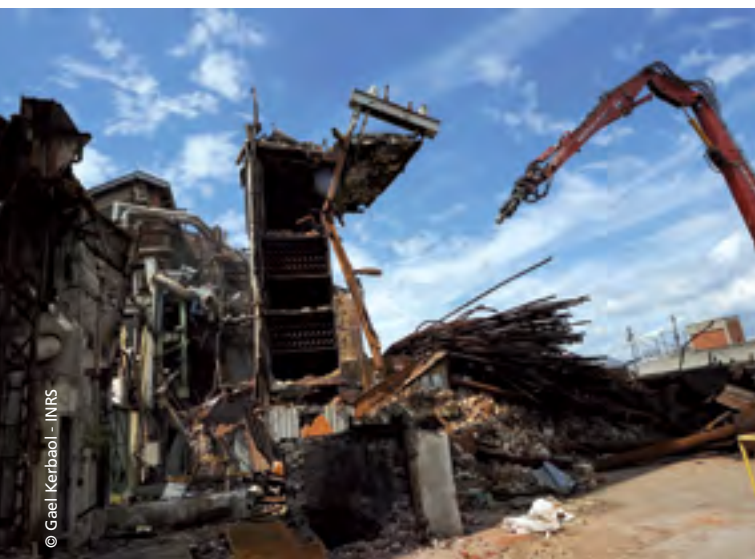
Démolition de structure métallique à la pince
