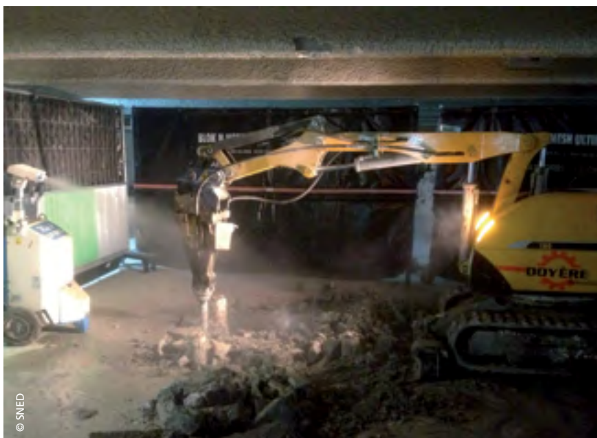
Abattage par voie humide des poussières à leur point d'émission
