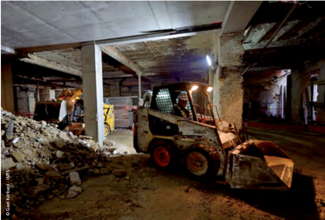
Coltinage mécanisé réalisé avec une mini-chargeuse
