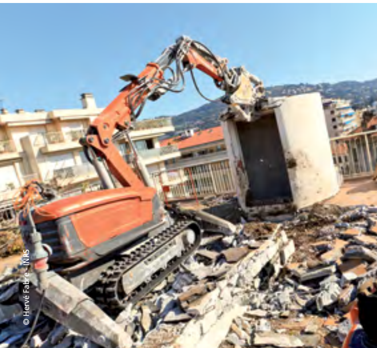
Écrêtage à l'aide d'un engin télécommandé équipé d'une pince en écrêtage
