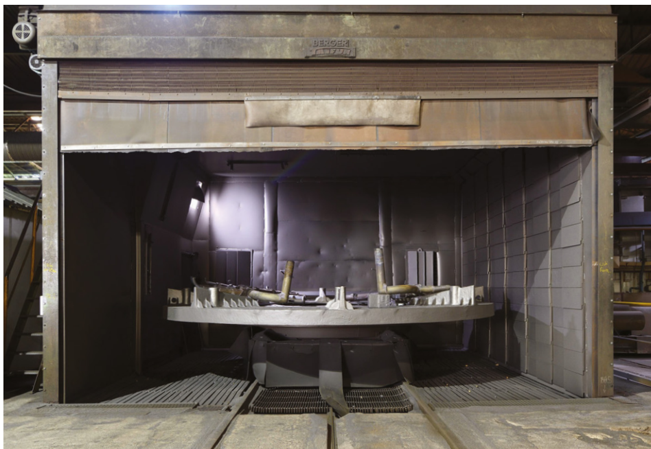
Une cabine de grenailage
