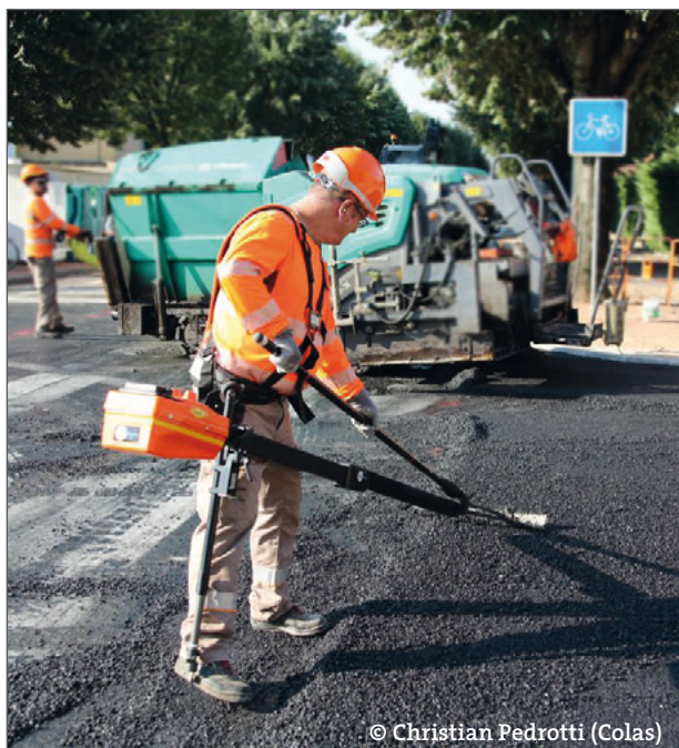
Photo 2 : Mise en œuvre d'enrobés avec l'Exopush
