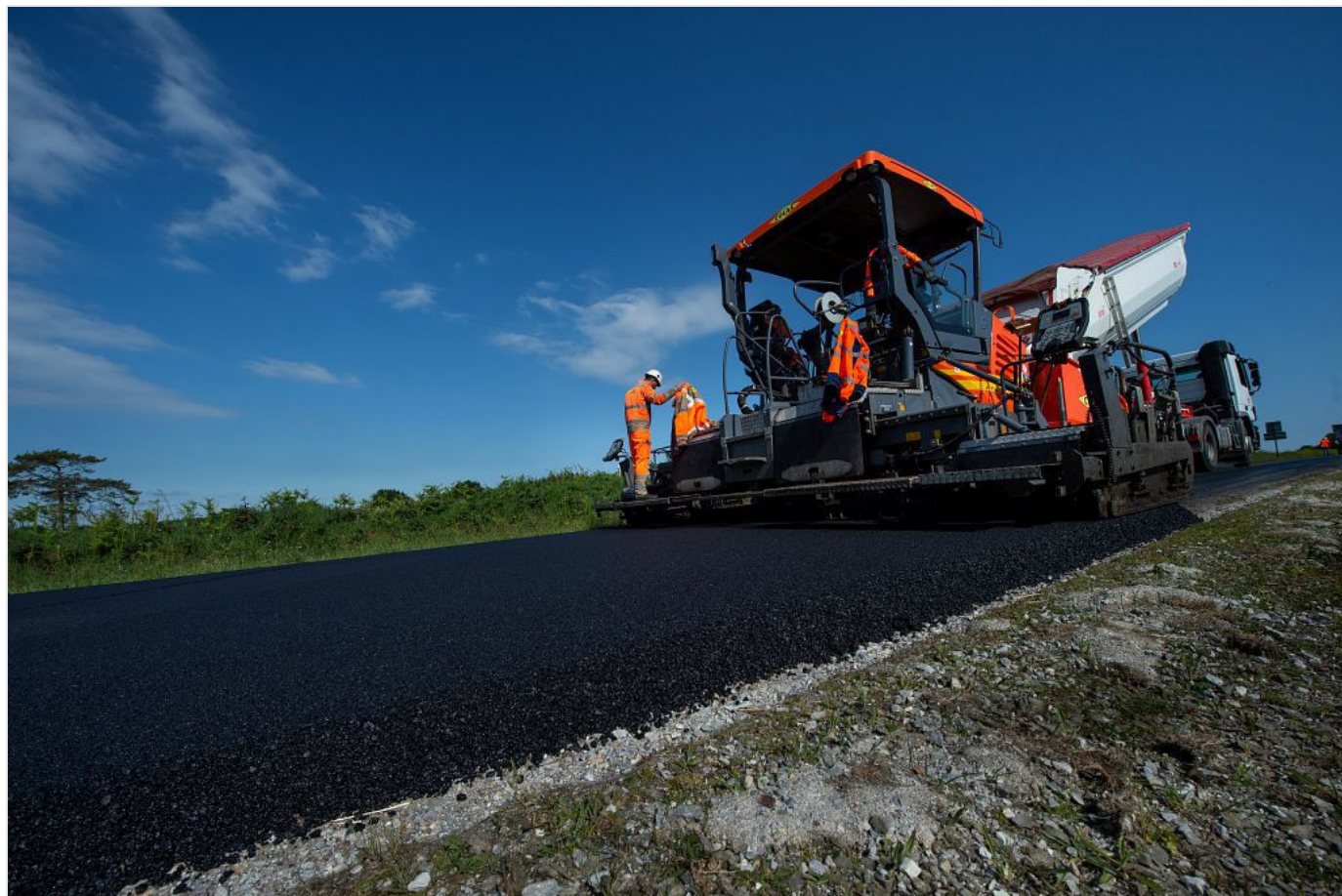
© Gaël Kerbaol/INRS Alimentation du finisseur en enrobé
