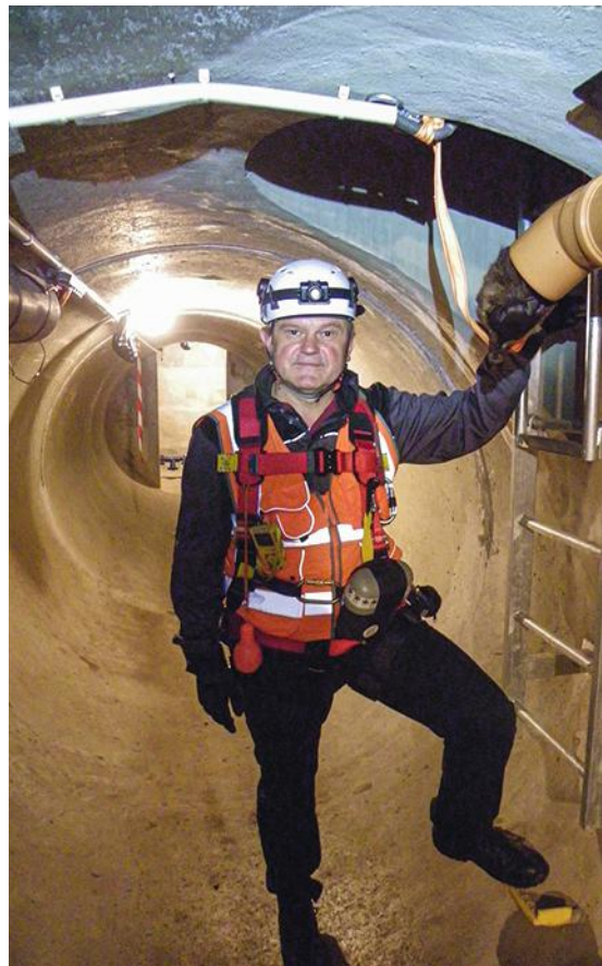
← PHOTO 2 Équipement type d'un opérateur évoluant dans un ouvrage d'assainissement : vêtements haute visibilité et gants de travail, casque à jugulaire équipé d'un système d'éclairage autonome, chaussures de sécurité, harnais antichute, masque auto-sauveteur et détecteur de gaz individuel.
