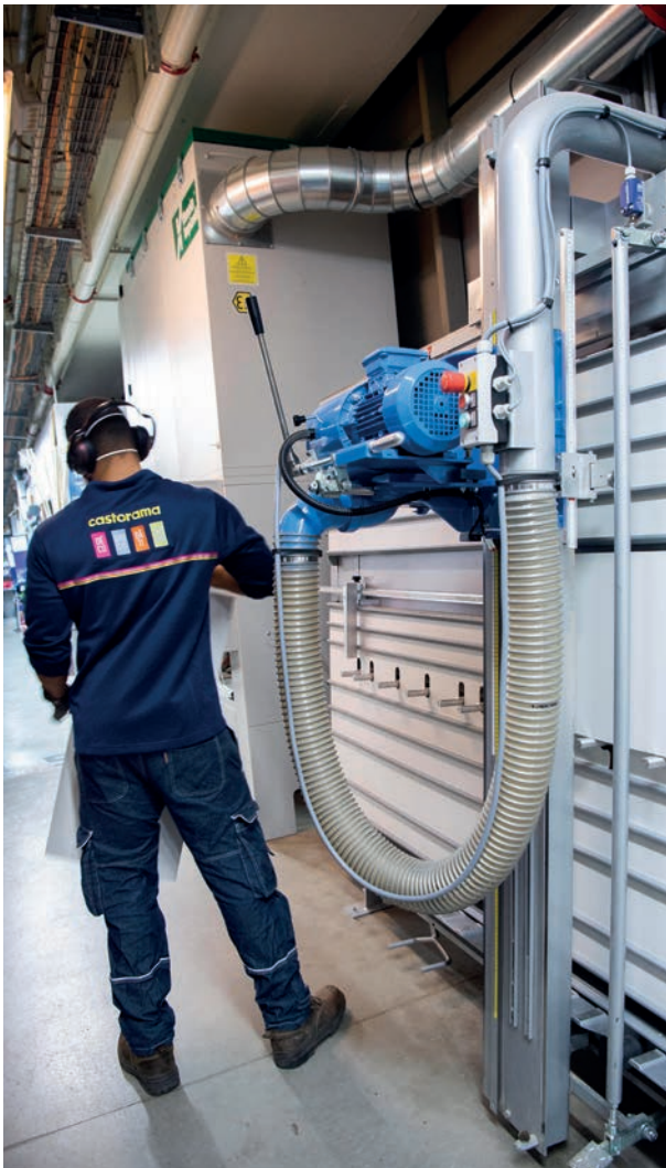
■ Scie à panneaux équipée d'un système d'aspiration des poussières
