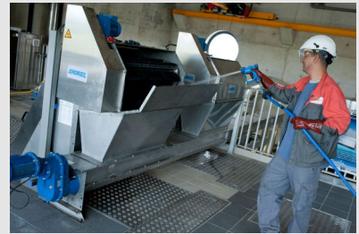
Nettoyage des tamiseurs de prétraitement dans une usine de dépollution
