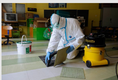
Remplacement de dalles d'un revêtement de sol collé initialement avec une colle contenant de l'amiante
